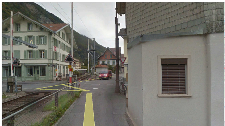
Abbildung 10: Einmündung Aareckstrasse in Marktgasse: falsche Markierung (Randlinie), ungenügende Sichtverhältnisse, zu eng für zweispurige Verkehrsführung (Google Earth, Zugriff 21.7.2016).
