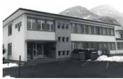
Abb. 5 erhaltenswertes Bürogebäude im Bauinventar
