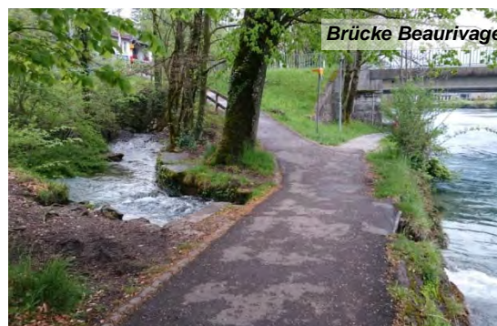
Abbildung 5 Bereich Aareaufweitung unterhalb Brücke, best. steile Rampe Blickrichtung Brücke Beurivage (nach Möglichkeit neue Linienführung mit weniger Gefälle)
