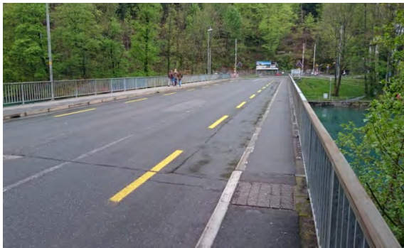
Abbildung 12 Trottoir oberwasserseitig Blickrichtung Talstation Harderbahn
