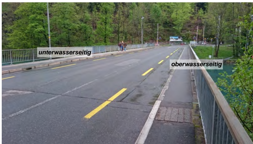
Abbildung 3 Brücke Beurivage, Blickrichtung Talstation Harderbahn
