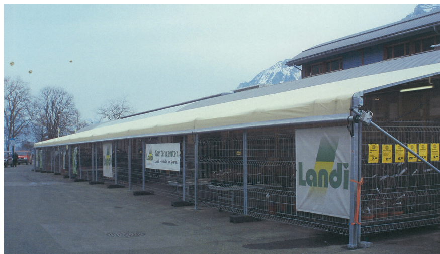
Abb. 13 Bestehende permanente Aussenverkaufsfläche mit beweglichem Witterungsschutz
