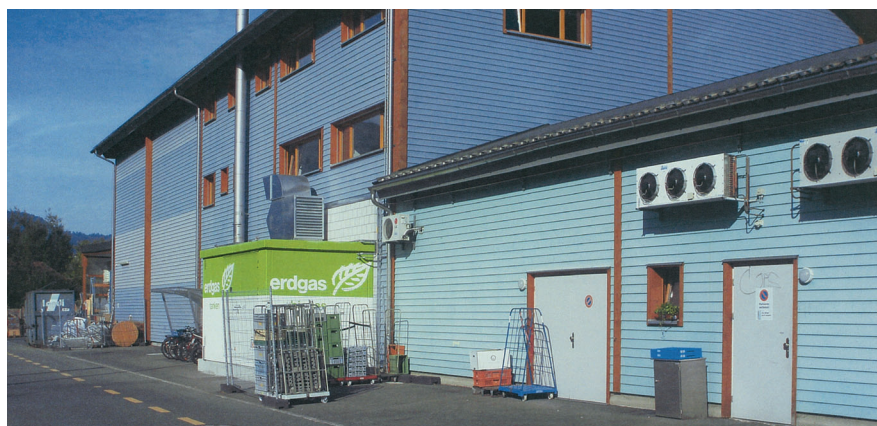
Abb. 15 Bestehende Vorplatzsituation entlang der Gemeindestrasse
