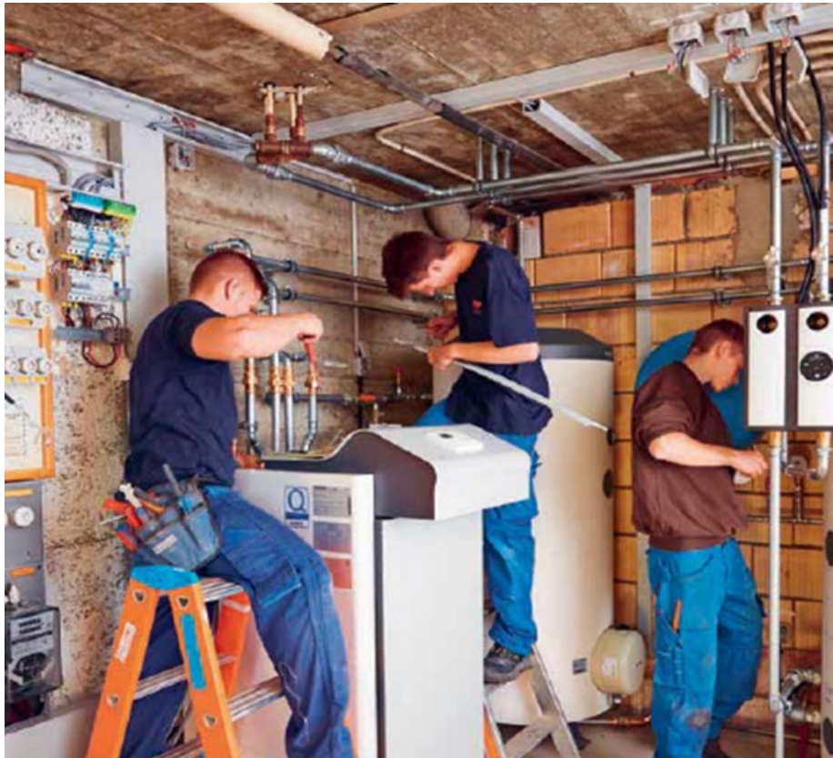
Wärmepumpeninstallateure «in Action»
