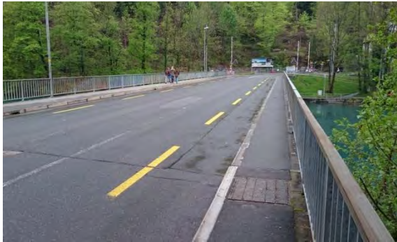
Abbildung 9 Trottoir oberwasserseitig Blickrichtung Talstation Harderbahn
