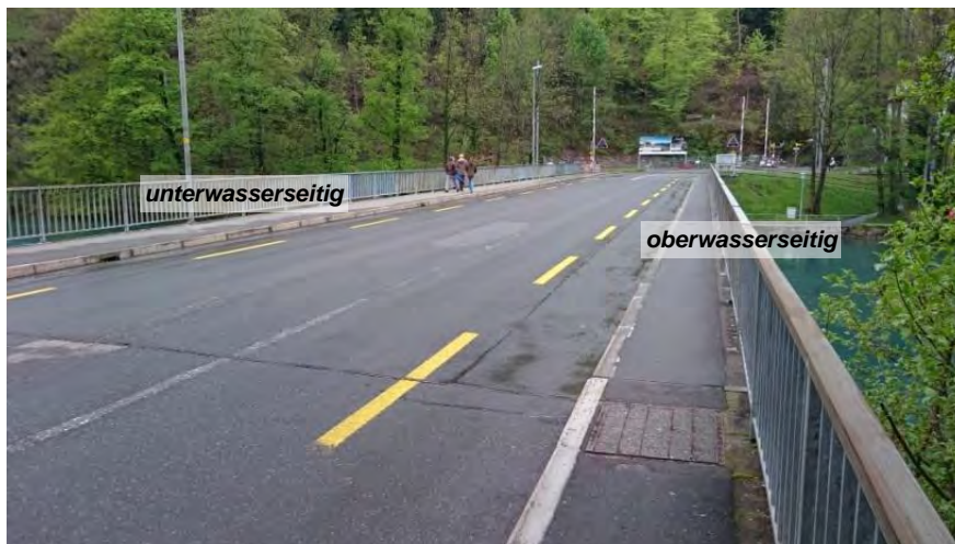
Abbildung 3 Brücke Beurivage, Blickrichtung Talstation Harderbahn
