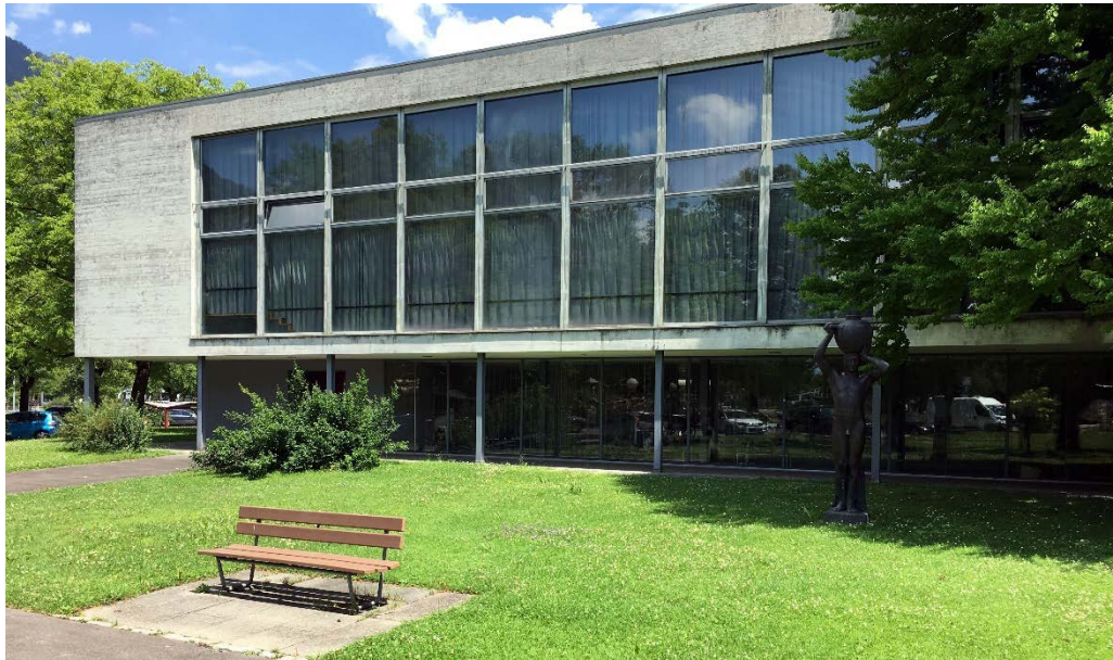
Abb. 1: Blick auf die Westfassade der Aula Alpenstrasse im heutigen Zustand
