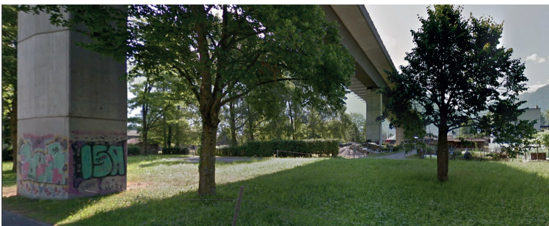
Abb. 4 Standort Goldswilviadukt, Blick von der Aare her. (Quelle: Google Street View)
