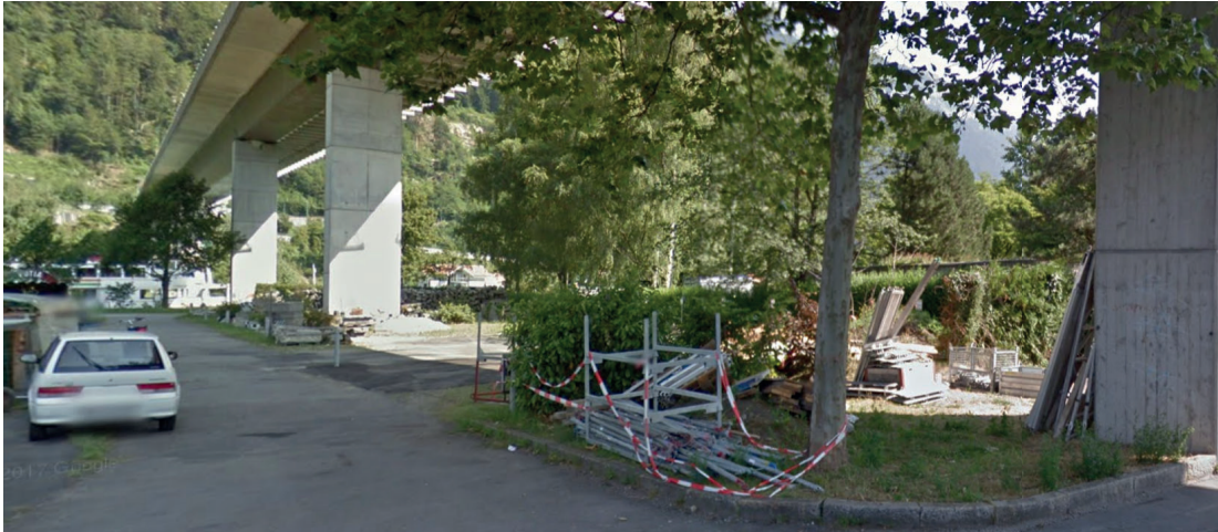
Abb. 3 Standort Goldswilviadukt, Blick von der Kammstrasse Richtung Aare. (Quelle: Google Street View)
