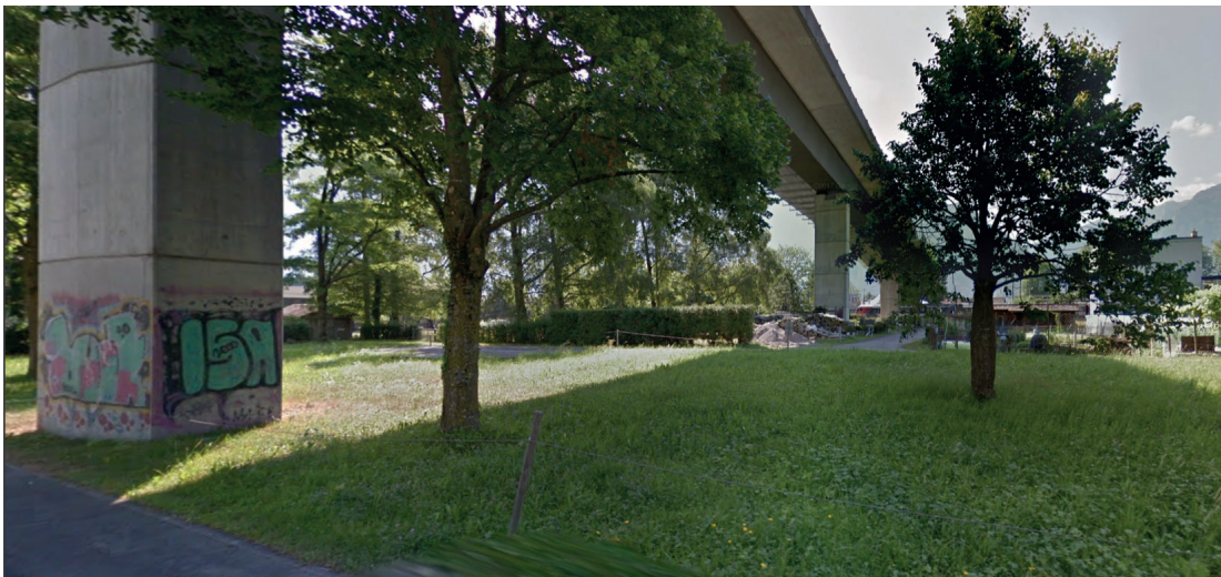
Abb. 3 Standort Goldswilviadukt, Blick von der Aare her. (Quelle: Google Street View)
